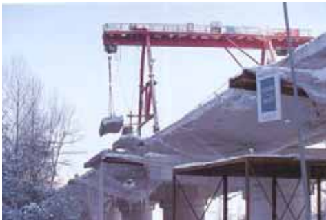
Bild 4: Abtrag der Aussenzone
