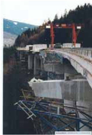
Bild 6: Montage der Aussentragwerke.
