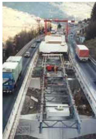
Bild 7: Betonieren der Innentragwerke
